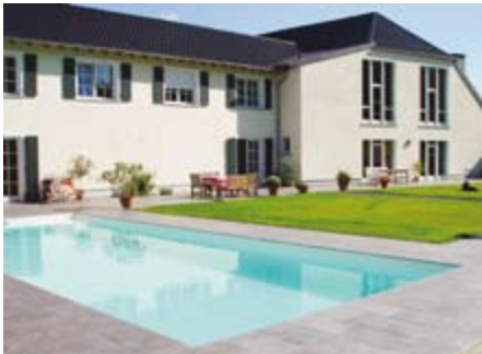
Sanierter Gutshof in Düren
