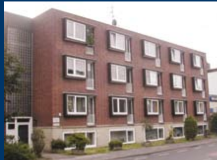
Wohnanlage in Frechen
