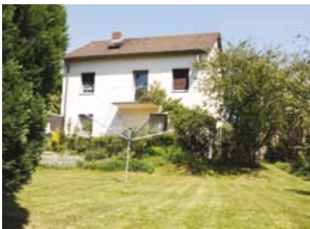
Einfamilienhaus in Sürth
